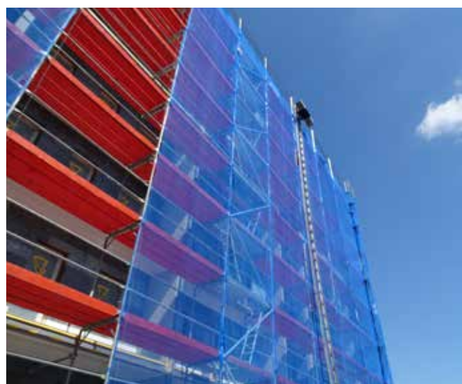
Anbau Wärmedämmverbundsystem, Leutewitzer Ring 70-82
