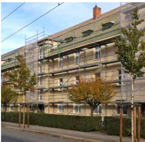
Sanierung Dach und Fassade: Steinbacher Straße
