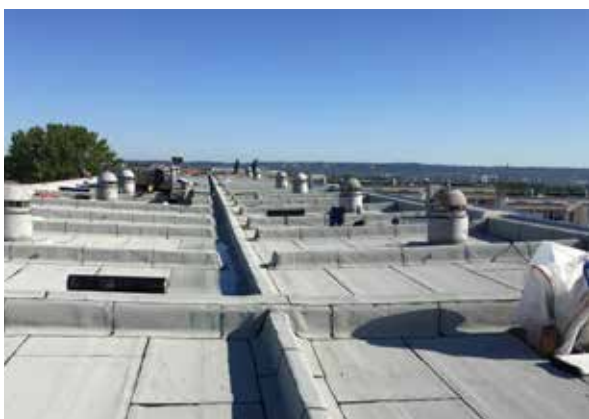
Dachsanierung in Gorbitz
