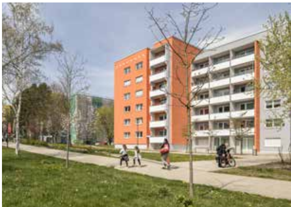
Modernisierung und Umbau, Leutewitzer Ring 21/23
