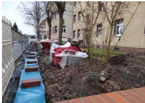
Sanierung Außenanlagen, Deubener Straße 34b-40c
