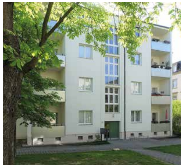
Sanierung Fassade, Döhlener Straße 30
