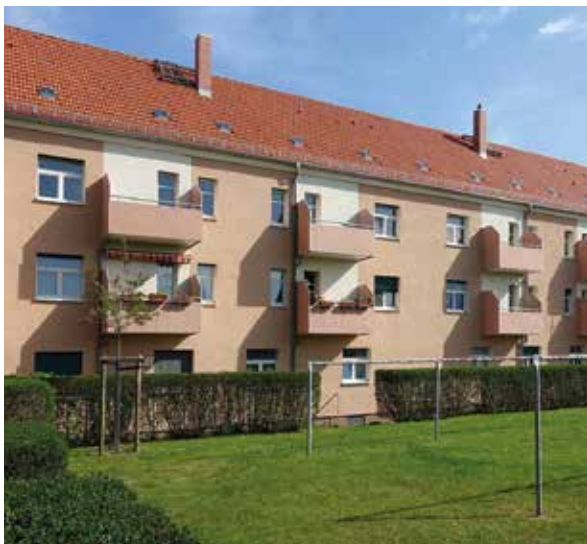
Sanierung Dach und Fassade, Clara-Zetkin-Straße
