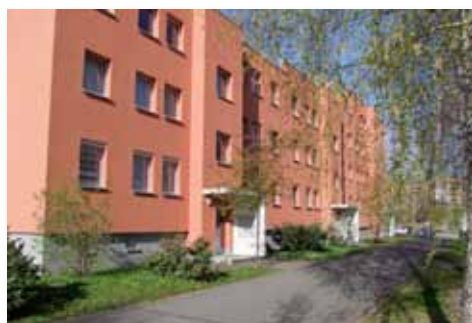
Stadtumbau in der Kräutersiedlung
