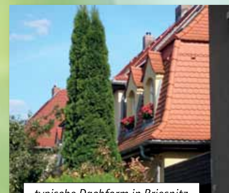
typische Dachform in Briesnitz
