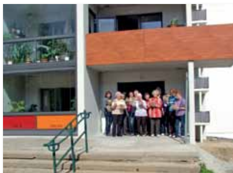
Neuer Eingangsbereich des NHV
