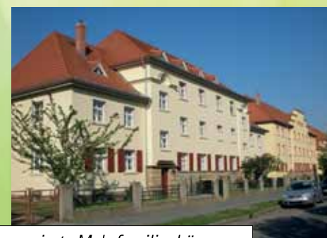
sanierete Mehrfamilienhäuser der EWG am Schulberg
