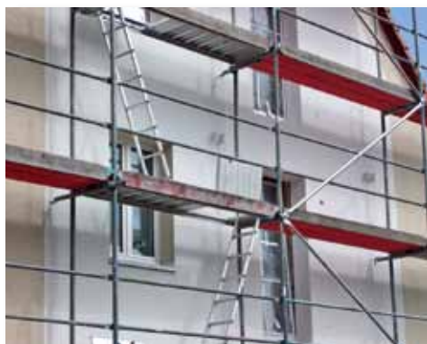
Sanierung in Dölzschen
