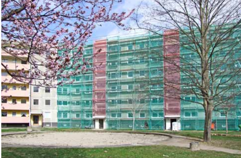
Fassadenarbeiten; Innenhof Leutewitzer Ring 46 – 82
