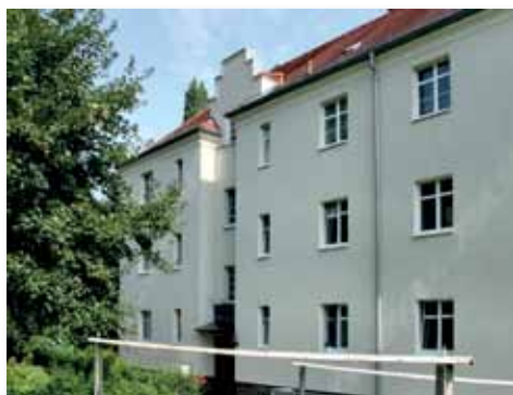
Saalhausener Straße 29 und 29 b, Hofseite
