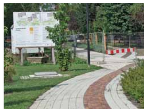
Klinkerband im fertigen Fußweg
