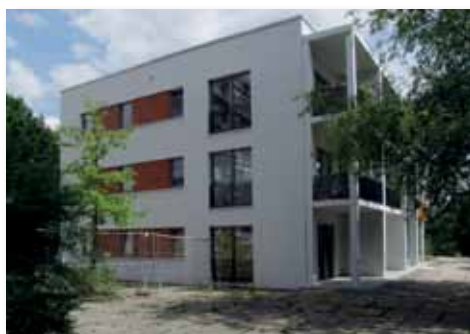
Westansicht kurz vor der Fertigstellung
