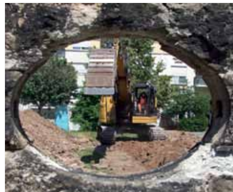
Einblick auf die Baustelle
