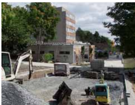
Bauarbeiten am Fußgängerbereich
