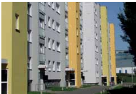
angebaute Aufzüge Hainbuchenstraße
