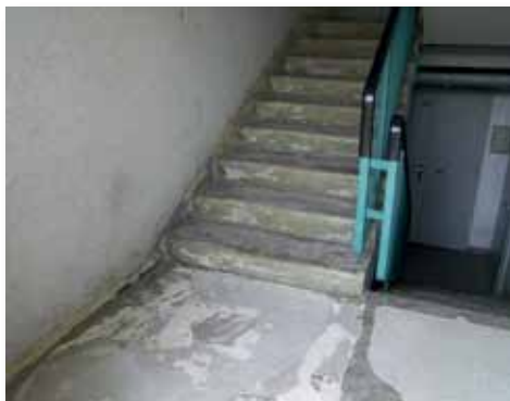
Treppenhaus während der Sanierung
