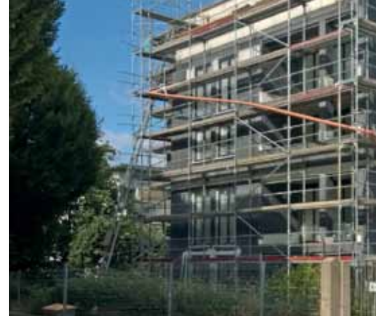
Neubau Mohorner Straße, Rohbau
