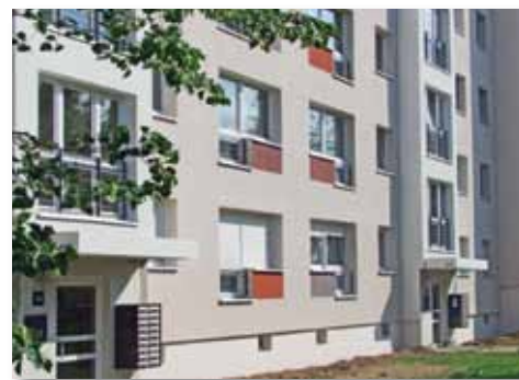
Leutewitzer Ring, sanierte Fassade
