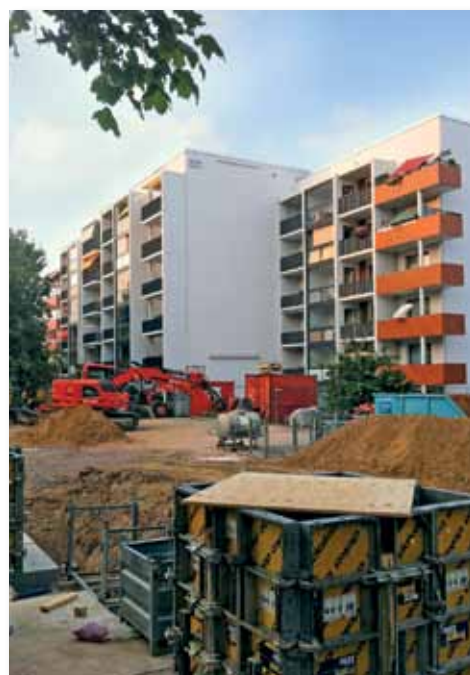
Baumaßnahme am Merianplatz
