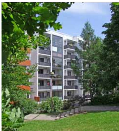
saniert Leutewitzer Ring 49 – 55
