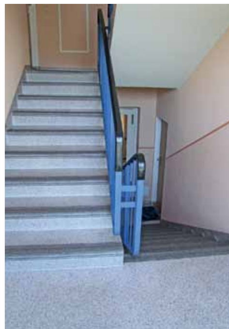
neues Treppenhaus, Braunsdorfer Straße 79
