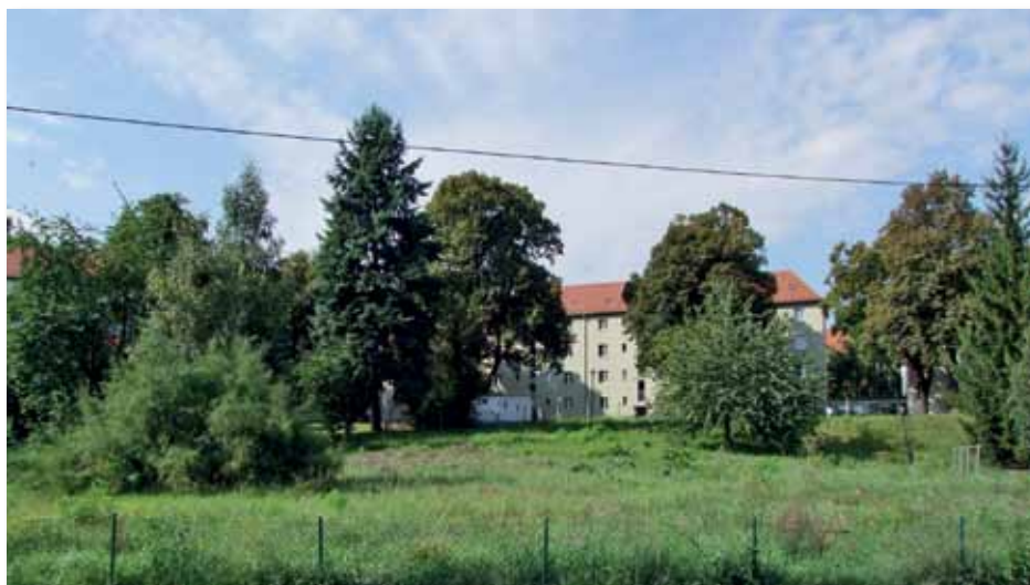
Baugrundstück, Blick vom Felix-Dahn-Weg zur Wilhelm-Raabe-Straße
