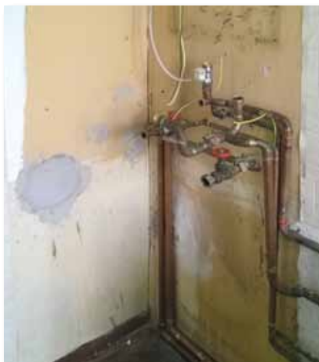
Baustelle nach Entfernung der Heiztherme
