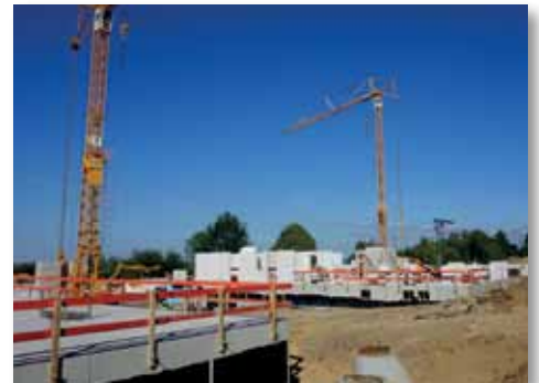
Die Keller sind fertig.
