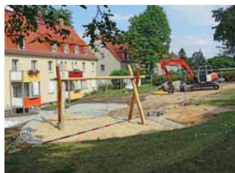
Neuer Spielplatz – noch im Bau
