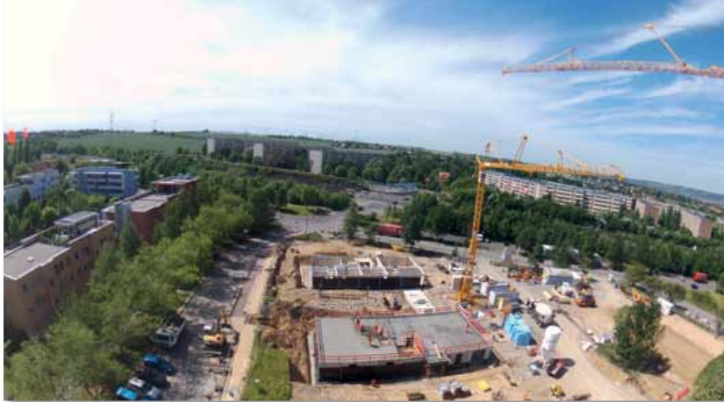
Baufeld der Kräuterterrassen
