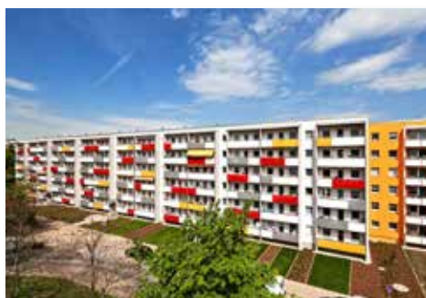
Leutewitzer Ring, Umbau und Modernisierung
