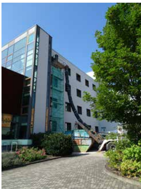
Umbau in der 4. Etage
