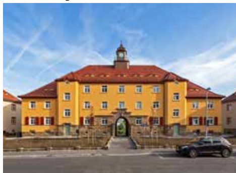
Borngaben, denkmalgerechte Sanierung
