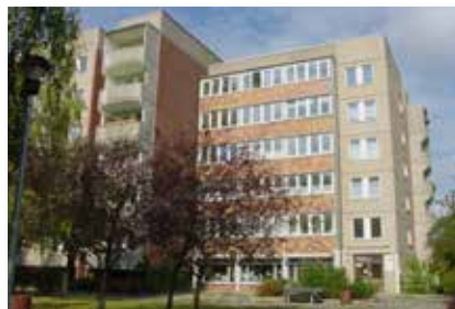
Leutewitzer Ring 21/23, noch unsaniert
