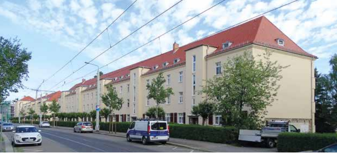
fertige Dach- und Fassadensanierung Steinbacher Straße 14b–24 und Hebbelstraße 43
