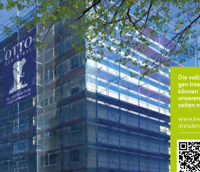
Baustelle Braunsdorfer Straße 31–45
