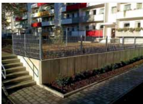
Hetzdorfer Straße, neue Wegeführung
