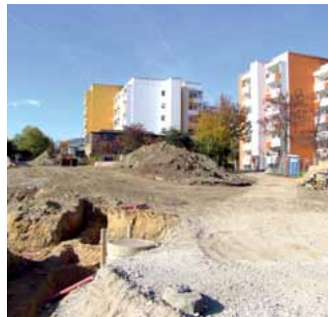
Mittelachse, städtische Baustelle
