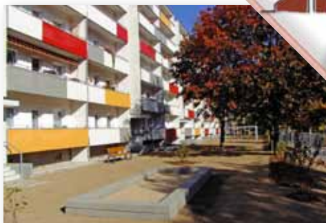
Hetzdorfer Straße, Innenhof
