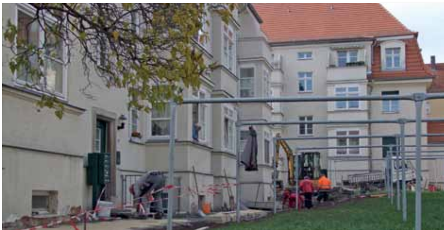
Verlegung neuer Gehwegsteine im Hof
