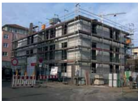
Baufortschritt Mohorner Straße 16
