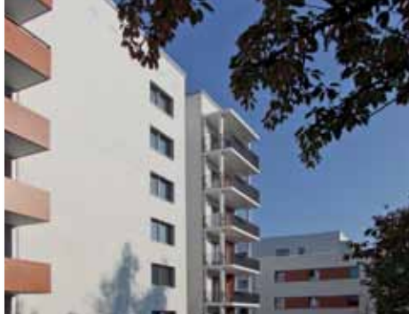
Fassade mit neuen Balkonen
