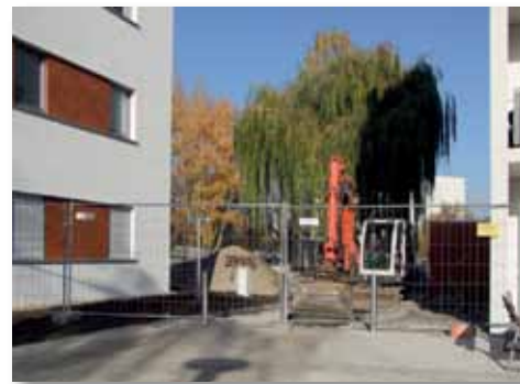
Entfernung der alten Wegeplatten
