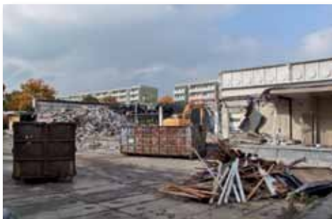
Abrissarbeiten an der Kaufhalle Malterstraße
