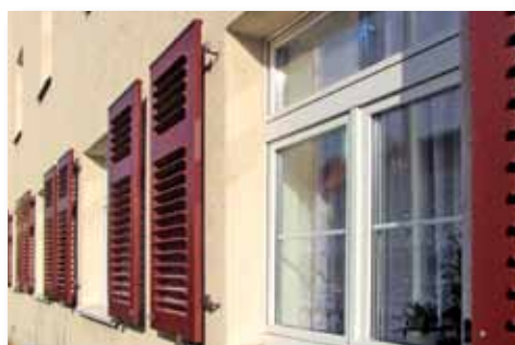
neue Klappläden an der Steinbacher Straße
