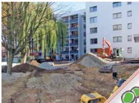
Bauarbeiten zum Sitzrondell
