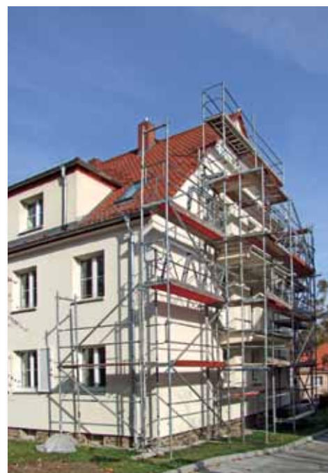
Fassadenarbeiten an der Hultschiner Straße 10
