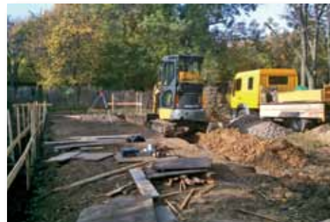
Schachtarbeiten für die Garagenfundamente
