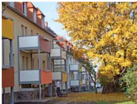
neue Balkone für Dölzchen
