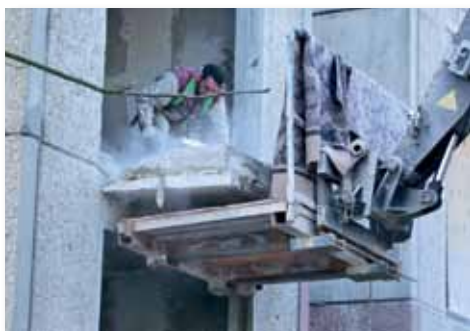
Abbrucharbeiten am Leutewitzer Ring
