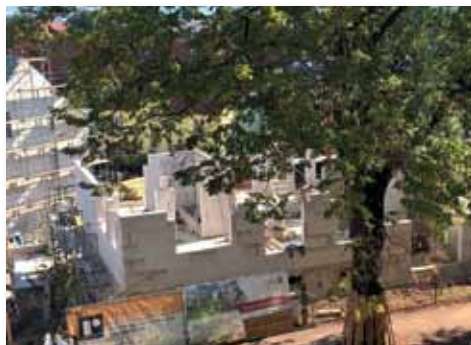
„Alte Ziegelei Briesnitz“ Rohbauarbeiten
