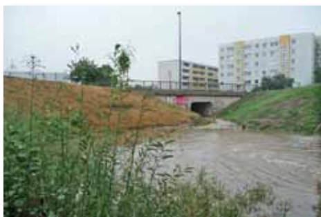
Tosbecken im September 2016
