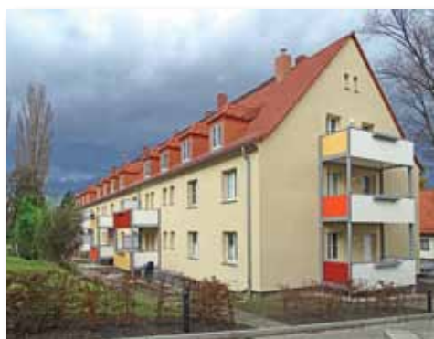
Südwesthang mit Balkonanbau
