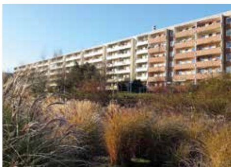
die letzten 2 unsanierten Eingänge „An der Kirche“
