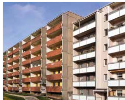
noch 4 unsanierte Hauseingänge
