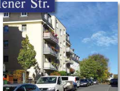
nördlicher Stummel der Döhlener Straße
