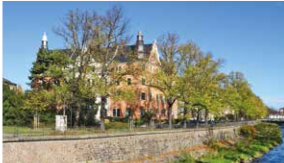
ehemaliger Reisewitzer Garten, Standort Wasserschlösschen
