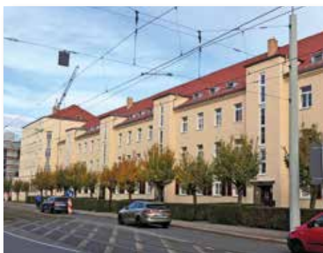
Steinbacher Straße, fertiger 1. Bauabschnitt
